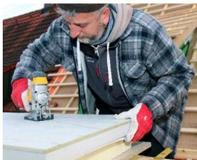
Einfacher Zuschnitt von CALOSTAT® Sandwich MW 60 auf der Baustelle mit einer Stichsäge.
