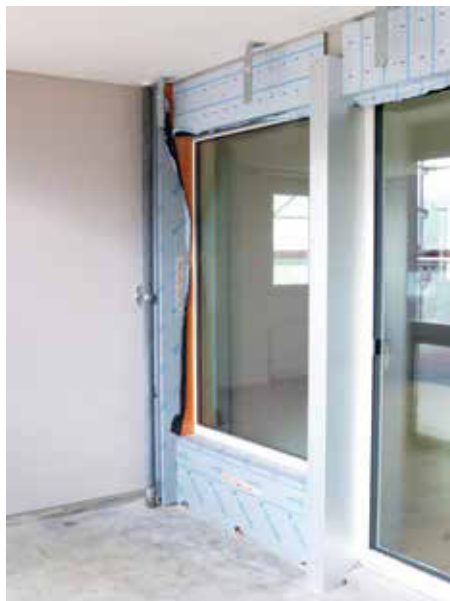
Fenster und Balkonzugang: Gut gedämmt mit Calostat.
