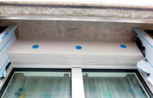
In Bereich der Fensterstürze wurde Calostat zweilagig mit 50 Millimeter Dicke eingesetzt.
