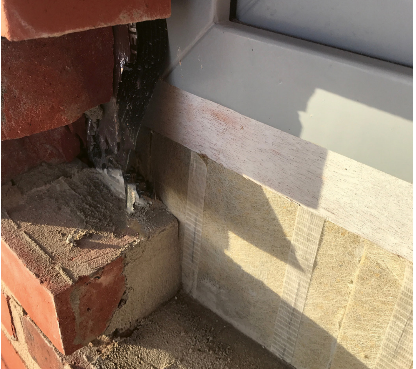
Detailaufnahme der Einbausituation: CALOSTAT® Sandwich ist eine schlanke und rein mineralische Dämmplatte, die auch die Denkmalschutzbehörden überzeugt
