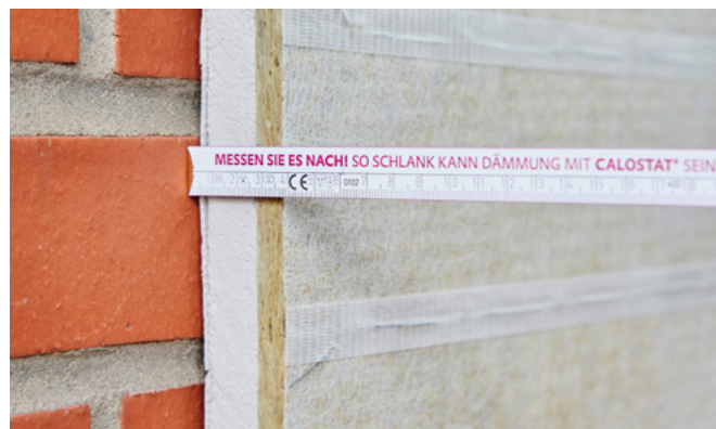
Das schlanke CALOSTAT® Sandwich eignet sich hervorragend bei der Sanierung von Backsteinfassaden
