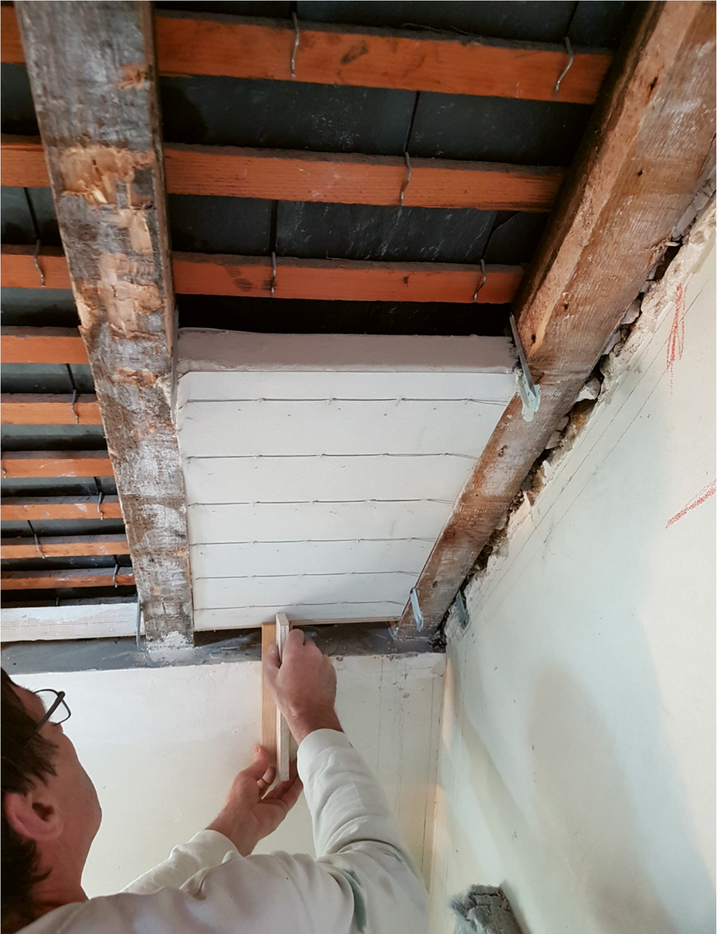
CALOSTAT® Sandwich F ermöglicht als Zwischensparrendämmung hohe Dämmleistung und Brandschutz in einem.
