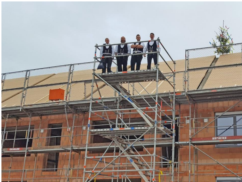
Richtspruch für die Energiespeicherhäuser mit Dämmung durch CALOSTAT® in Herzogenaurach
